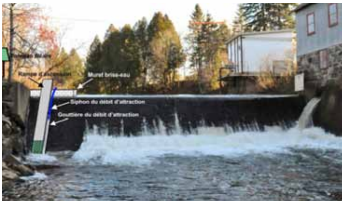
Exemple d'aménagement d'échelle à anguille sur un barrage
