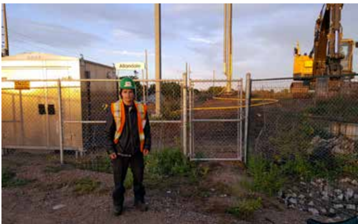
Élie Lainé, surveillant du chantier Allendale. Photo : Mélanie Vincent
